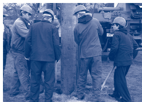
Auszubildende beim Kontrollieren eines Mastes
